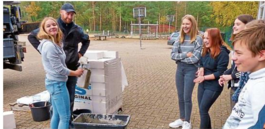
Ein Kran markierte auf dem Schulhof den Stand der Firma Meyerholz, wo die Jugendlichen sich im Zimmermanns- und Maurerhandwerk ausprobieren und Hölzer zusammenfügen oder eine Mauer errichten konnten.
